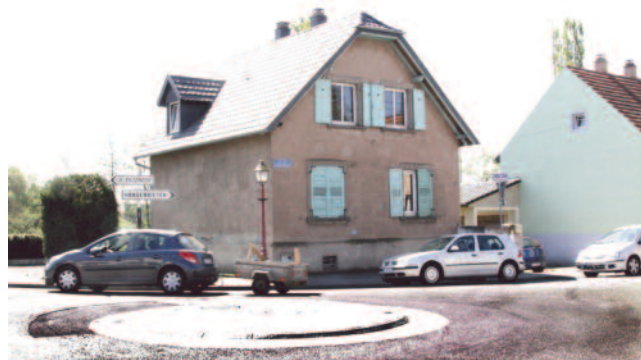
La maison sera démolie et l'espace ainsi dégagé permettra de réaménager le carrefour.
