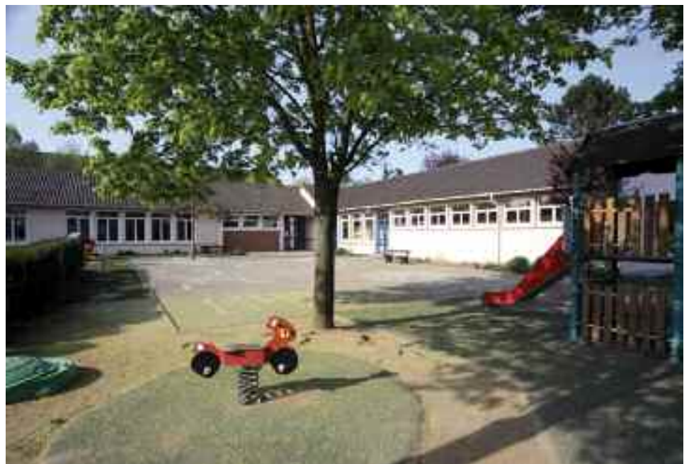
L'école, grosse consommatrice d'énergie et plus grosse productrice de CO 2 . Des travaux permettront de réduire la facture et la pollution avec un retour sur investissement très rapide.
