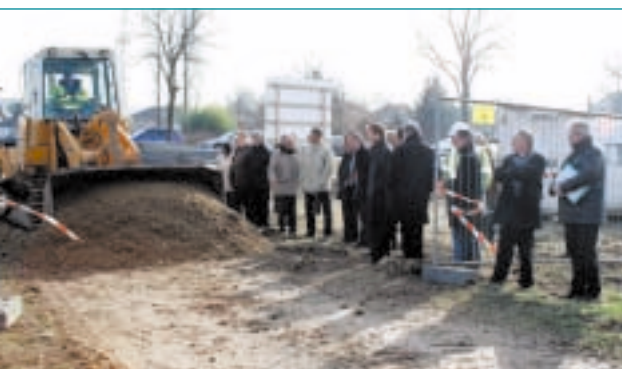
Le premier coup de pelle est de nos jours un premier coup de bulldozer ! A la fin des travaux de voirie et de mise en place des réseaux on aura, en plus de la terre végétale (qui pour qu'elle ne soit pas mélangée avec des gravats est stockée en bordure de lotissement pour les travaux puis remise en place), déplacé 40000 tonnes de tout venant, 8000 tonnes de mélange gravier et sable servant de lit aux tuyaux d'assainissement, mis en place 1450 mètres de collecteurs principaux, 350 mètres de collecteurs secondaires et 500 ml de branchement. La desserte en eau nécessite la même longueur de tuyauterie que celle de l'assainissement, à laquelle il faut rajouter la longueur du maillage de desserte des lots. L'assainissement est posé à une profondeur pouvant aller jusqu'à 4 mètres 50 contre 2 mètres 50 généralement. Une fois les réseaux posés la voirie sera mise en place de façon provisoire, c'est-à-dire d'une épaisseur inférieure de 20 cm à la voirie définitive qui sera posée après deux années pour éviter qu'elle ne soit abîmée durant les travaux de construction et assurer une belle unité visuelle.
